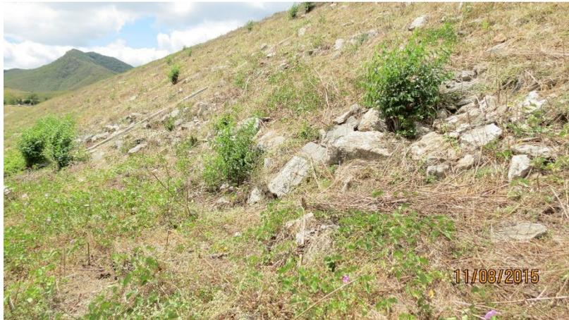
Figura 2 – Rock-fill com inclinação 2,0(H):1,0(V)
