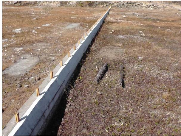
*Figura 4 – Vista do cordão de fixação do vertedouro (cota 116,35m)*
